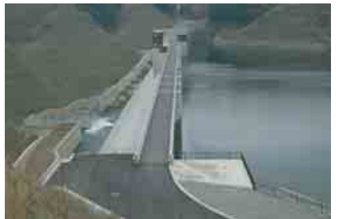
湛水実験中で、毎秒3.5トンで放水
