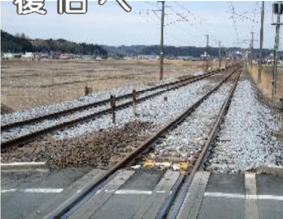
JR常磐線の工事が当初の見込みより順調にすすみ、高萩駅(4/7)までにつづき、いわき駅まで間もなく復旧予定(4/11)です。
