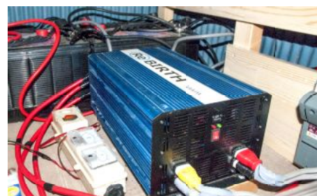
直流24V→交流100V、30Aのインバーター
